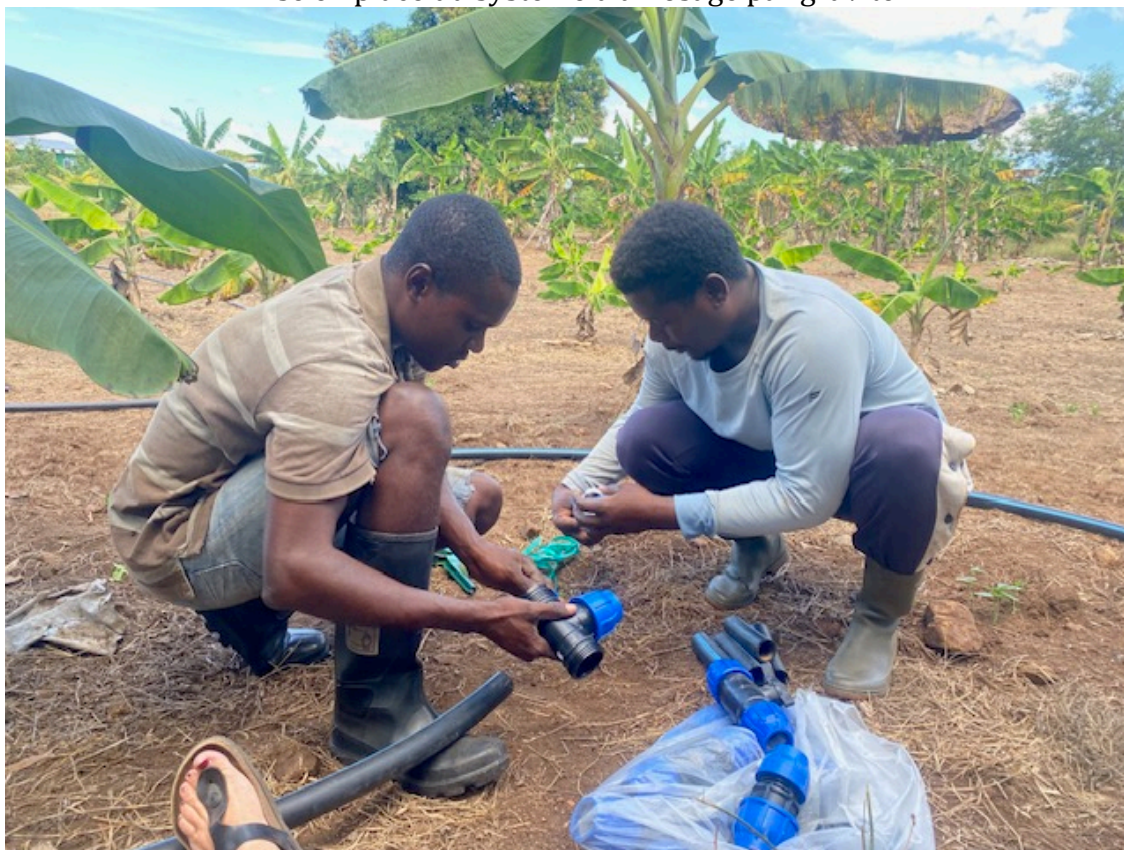
Mise en place du système d'arrosage par gravité
